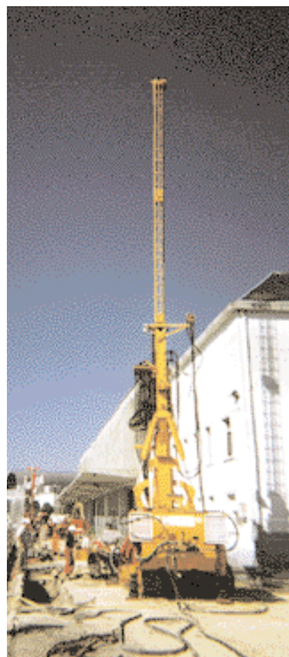
Atelier de jet grouting
