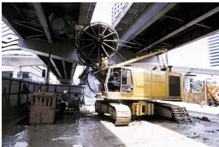
Outillage "KS court" en perforation sous un "fly-over"
