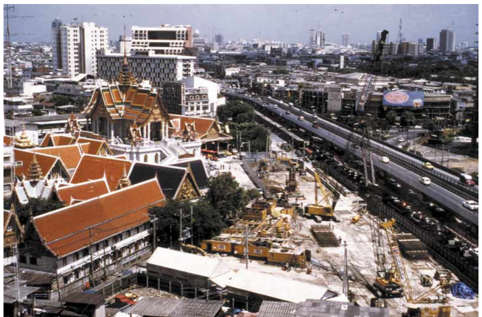
Vue générale des travaux de la station Samyan
