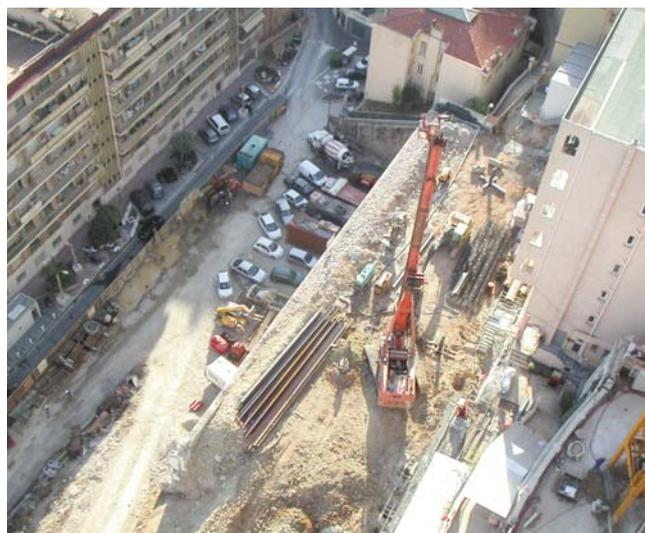
*Exécution des pieux de soutènement dans la zone Plati*
