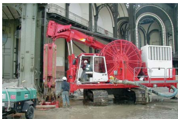
Réalisation de la paroi moulée
