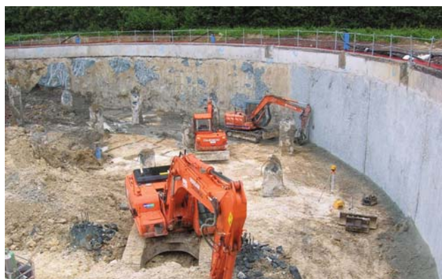
Paroi en cours de rabotage
