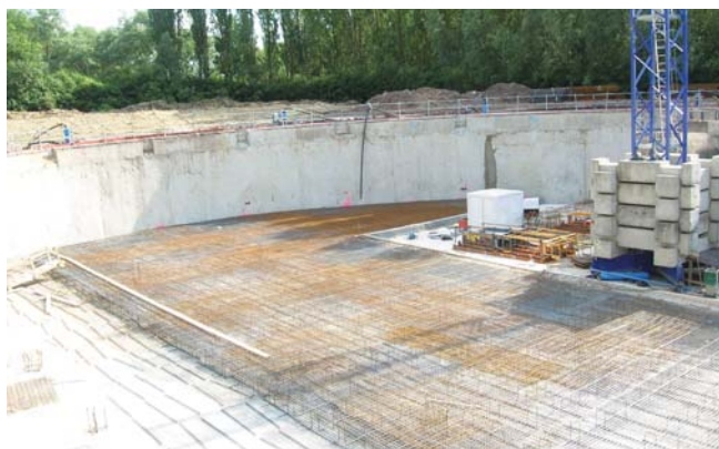
Réalisation du radier
