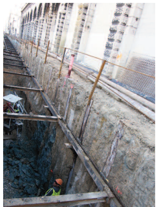
Vue de la paroi Geomix > en cours de terrassement
