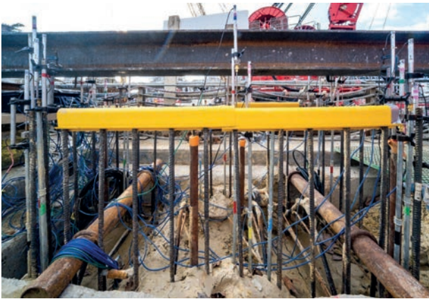
Tête de la barrette d'essai avec instrumentation en place
