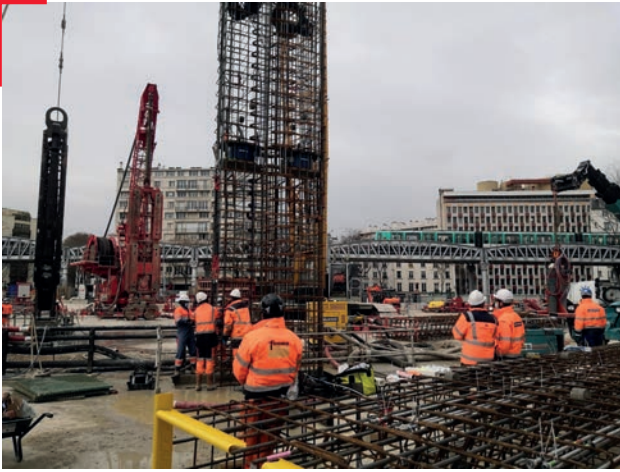
Insertion de la cage équipée
