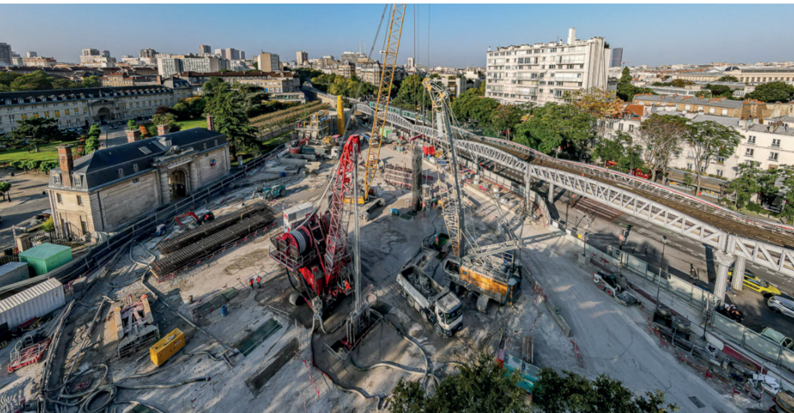
Vue aérienne de la perforation des barrettes
