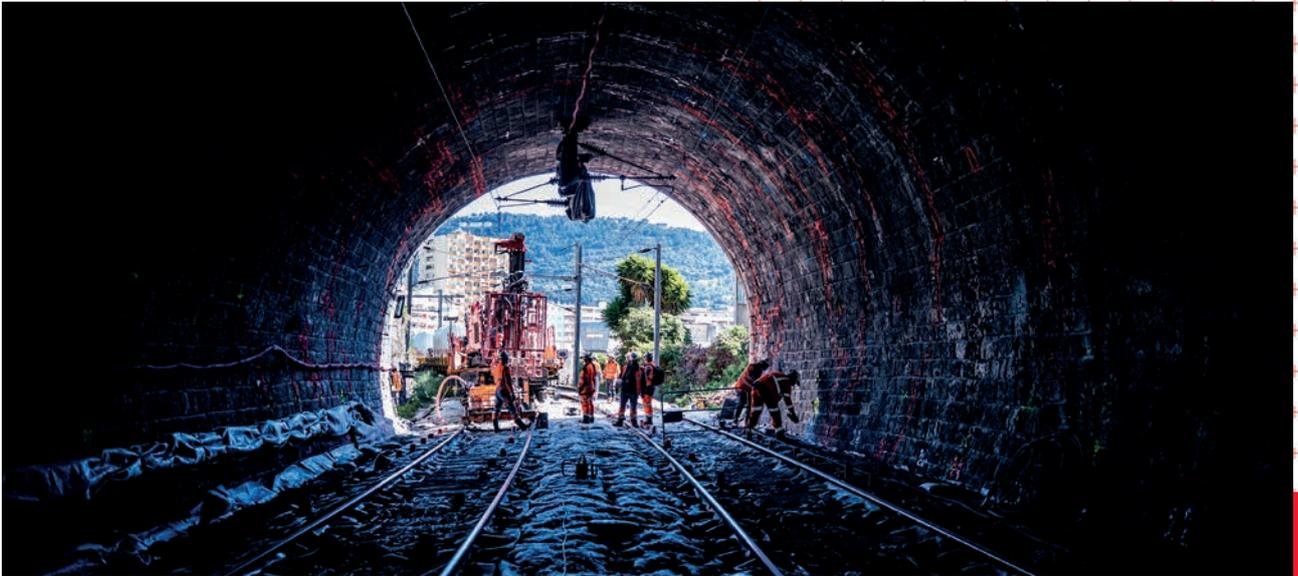
Après avoir préparé la zone de travaux (installation d'un système de suivi des voies, mise en place de protections en plate-forme et sur les supports caténaire, décapage de la voûte), les forages sous le radier ont démarré. Une foreuse classique couplée à un système de récupération et de recyclage du fluide de forage a été mise en place sur le train.
