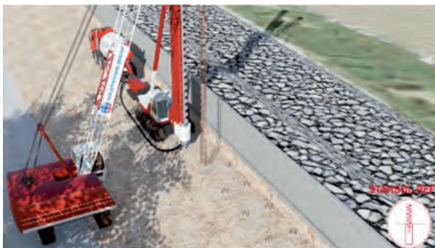
Image de synthèse de la réalisation des pieux en section courante.
