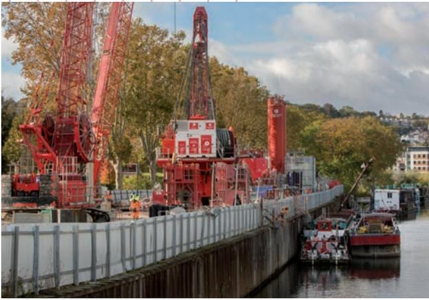
Le nouvel outillage Twin Soil a aussi fait son entrée pour traverser les pieux d'un ancien quai. À noter que les cages d'armature sont levées depuis des barges stationnées à quai.
