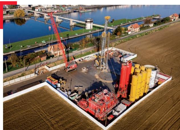
**Sur Valenton, la paroi moulée, terminée début juillet, a laissé place à des travaux de radier injecté (hauteur de 5 m dans le calcaire grossier fissuré). Puis une étanchéité entre la paroi moulée**
