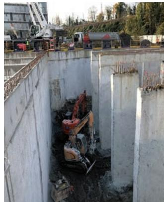
Dans l'emprise principale, les parois moulées et barrettes du bilobe sont terminées. Le niveau d'excavation intermédiaire est atteint. Fin novembre, Bessac a lancé son micro-tunnelier de 1,8 m de diamètre pour creuser les 600 m séparant la Station de Dépollution de Eaux
