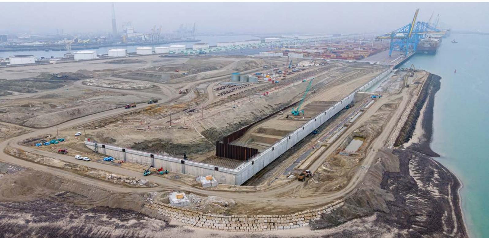
Le deuxième ouvrage d'isolement est actuellement en préparation, pour une mise en eau, en début d'année 2022, de la deuxième des trois « boîtes » divisant la zone digue.
