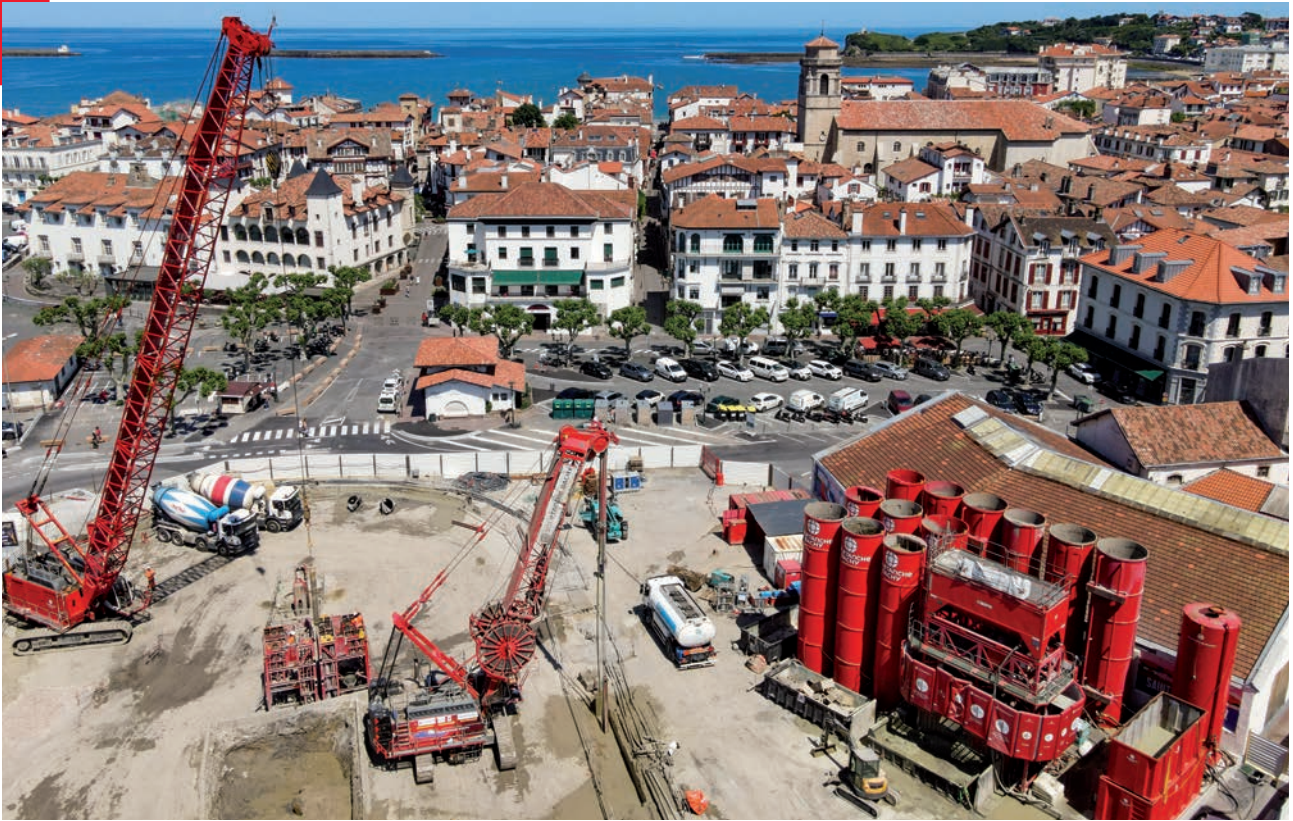
Vue d'ensemble, excavation et bétonnage en cours
