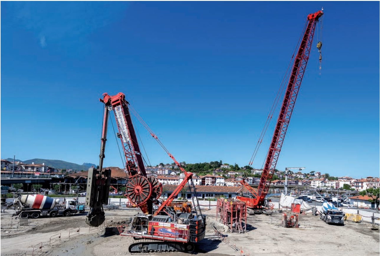
Excavation mixte à la benne KS / Twinsoil
