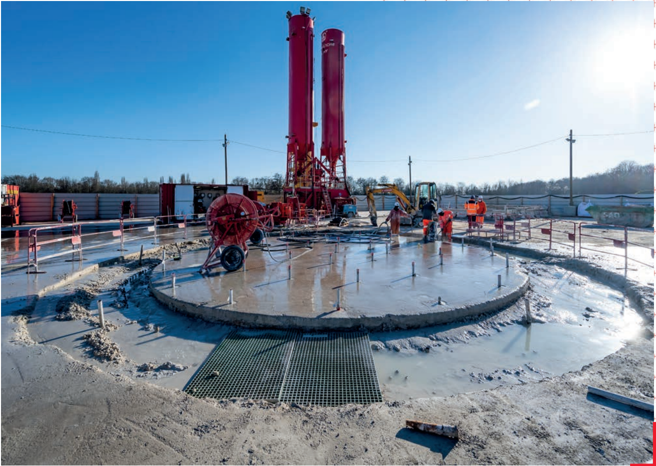
Enfin, après Valenton et Vigneux-sur-Seine, le groupement mené par Soletanche Bachy devrait intervenir sur une parcelle à Orly pour démarrer les travaux d'un dernier puits en paroi moulée d'un diamètre intérieur de 8 m et d'une profondeur de 45 m.
