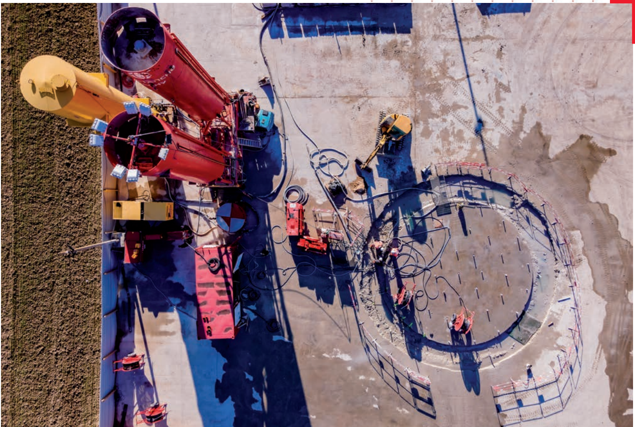
Enfin, après Valenton et Vigneux-sur-Seine, le groupement mené par Soletanche Bachy devrait intervenir sur une parcelle à Orly pour démarrer les travaux d'un dernier puits en paroi moulée d'un diamètre intérieur de 8 m et d'une profondeur de 45 m.
