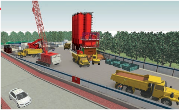
Vue 3D des installations de chantier de paroi moulée sur l'ouvrage Square de l'eau
