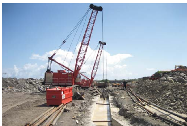
Excavation de la paroi moulée en rive droite
