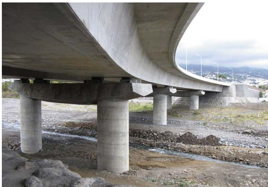
Vue de l'ouvrage terminé depuis la culée en rive droite
