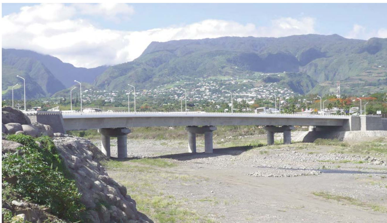
Vue d'ensemble de l'ouvrage terminé
