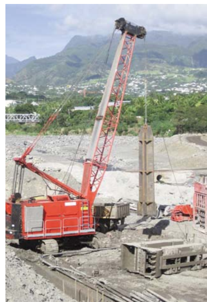
Trépanage pour l'excavation des barrettes sur la pile P2
