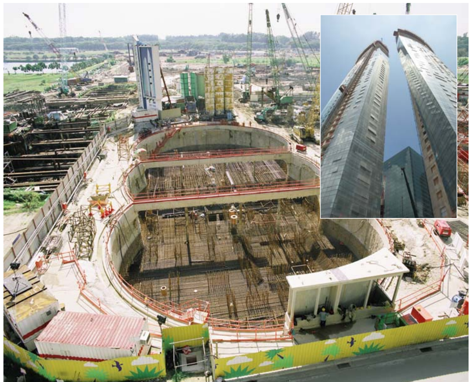
Vue de la fouille après terrassement, avec la présence au centre des têtes de barrettes
