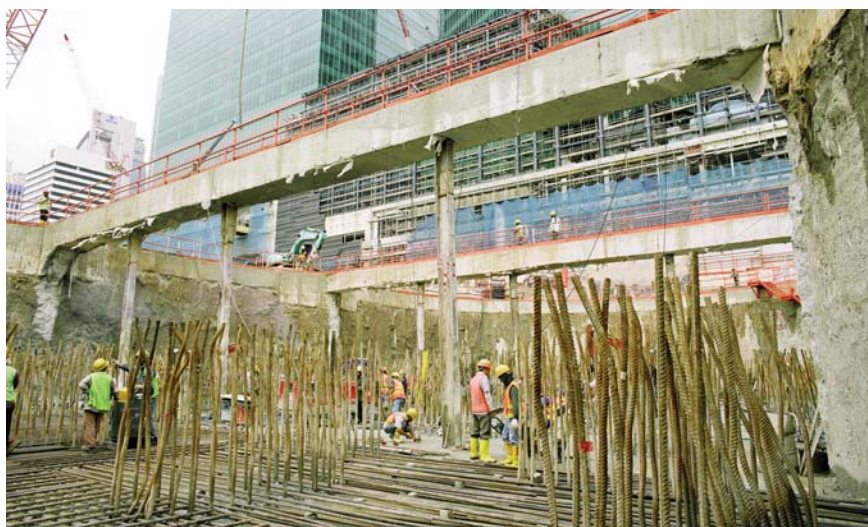
Scellement des aciers de liaison pour le radier de 3 m d'épaisseur
