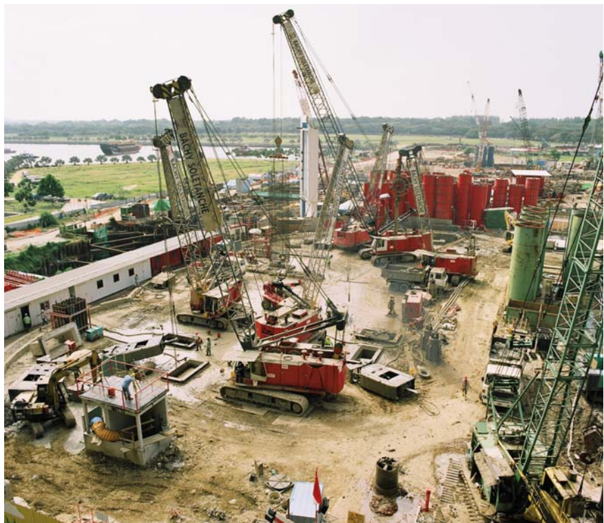
Vue d'ensemble du chantier avec 6 ateliers d'excavation
