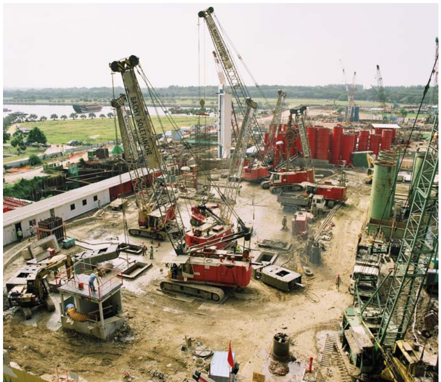
Vue d'ensemble du chantier avec 6 ateliers d'excavation
