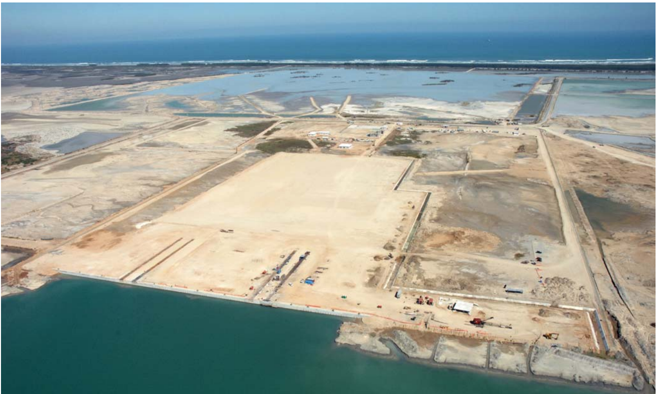
Vue aérienne du chantier
