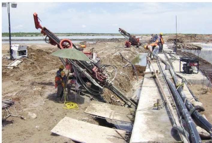
Perforation et équipement des tirants d'ancrage
