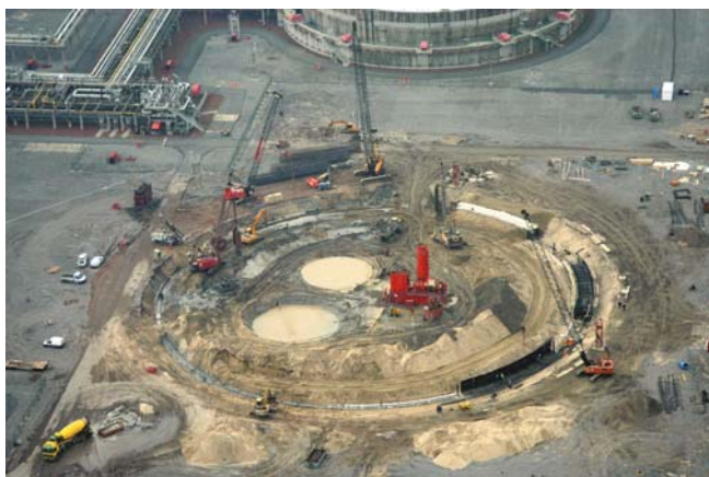
Réalisation de la paroi moulée
