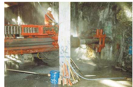
Jet grouting en cours
