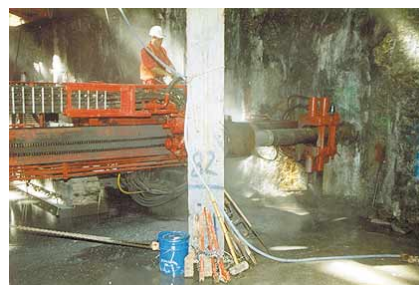
Jet grouting en cours
