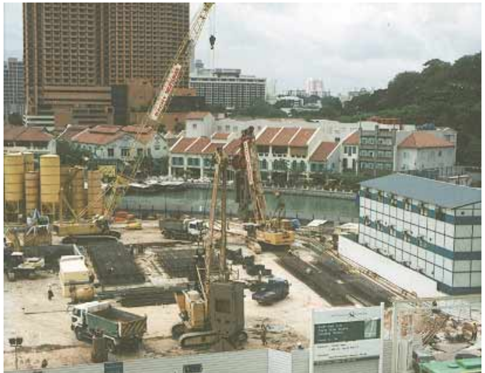
KS 3000 et benne à câble en cours d'excavation
