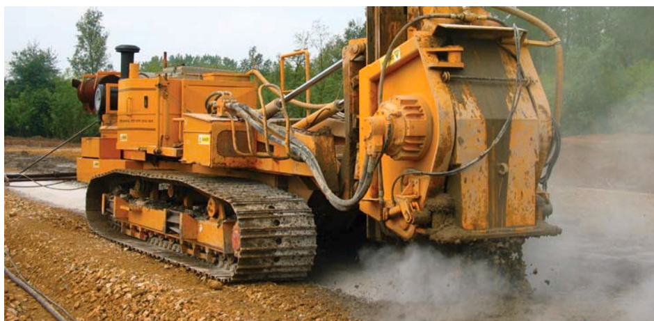
Réalisation de 21 000 m 3 de Trenchmix® pour fondation d'une plate-forme de stockage.
