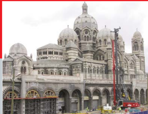
FRANCE - Marseille Axe Littoral 1 700 m 2 de soutènement en paroi Geomix®
