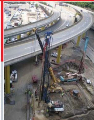
ETATS-UNIS - Pittsburgh North Shore Collector 10 000 m 2 de paroi Geomix® de soutènement
