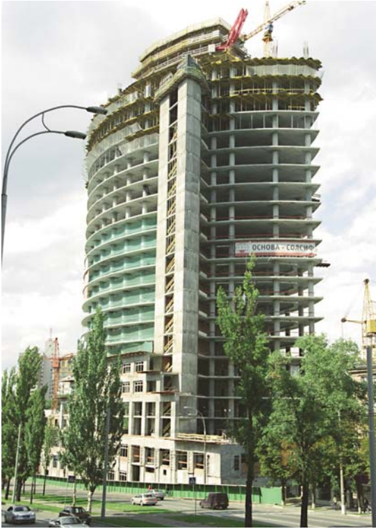
Exécution de la tour de 131 m de hauteur
