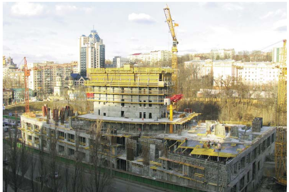
Début de la superstructure
