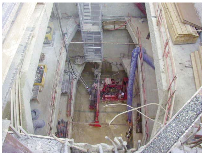
Exécution de la voûte parapluie
