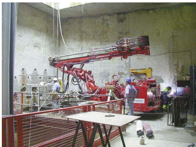
Opération d'injection dans le puits Victor Hugo
