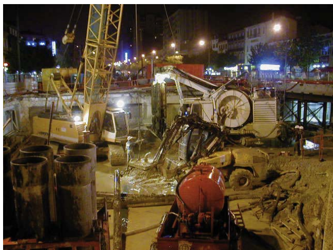
Excavation de la paroi moulée à l'aide d'une HC03
