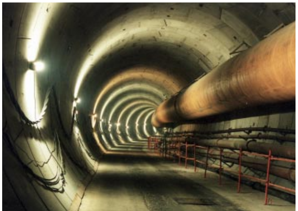
Section de tunnel avec radier coulé à l'avancement
