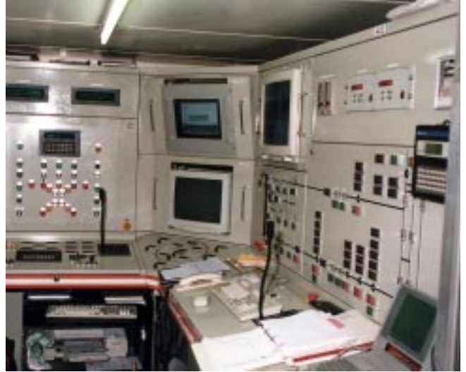
Poste de contrôle du tunnelier
