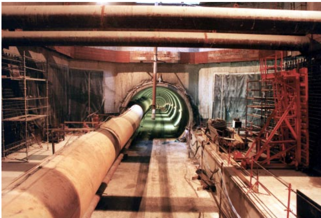
Traversée de la station Pavé de Lille
