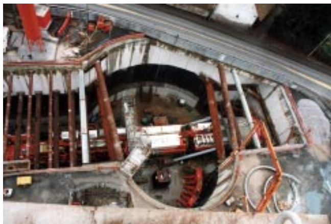
Montage du tunnelier - Station Louis-Constant
