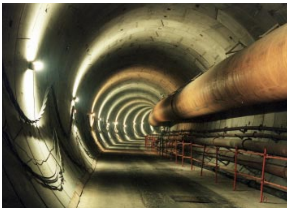
Section de tunnel avec radier coulé à l'avancement
