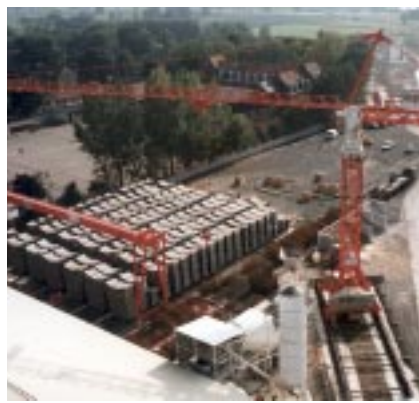
Fabrication et stockage des voussoirs
