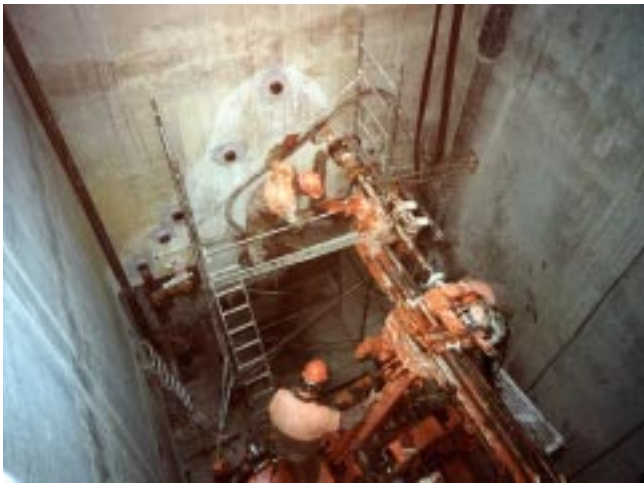
Réalisation des forages horizontaux
