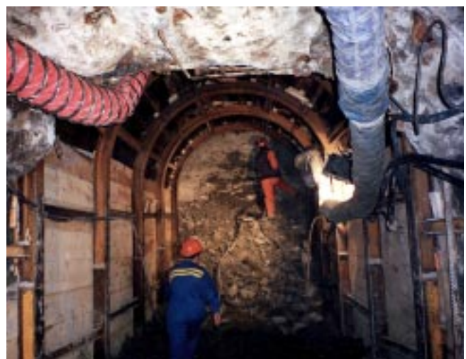
Galerie d'accès en cours d'excavation
