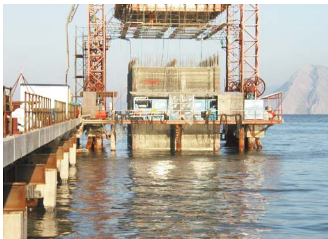
Fabrication des caissons
