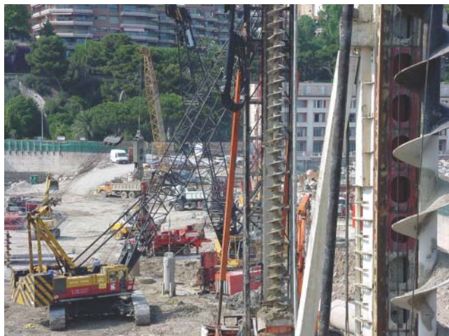
Travaux de pieux de fondations
