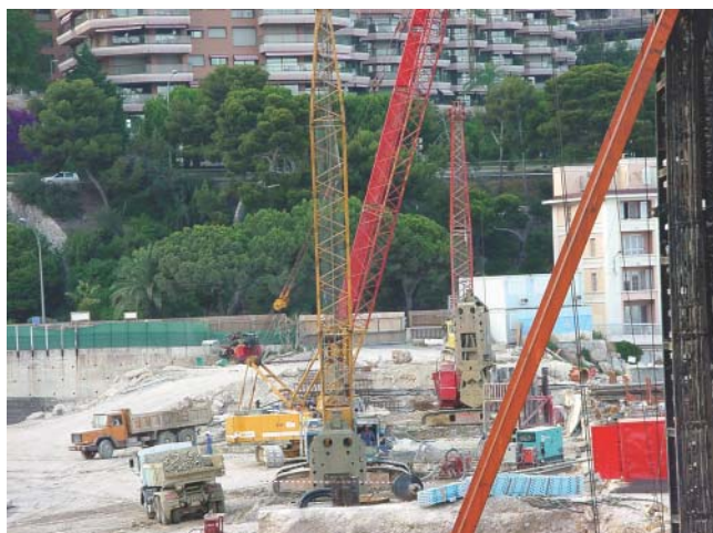
Travaux de barrettes de fondations
