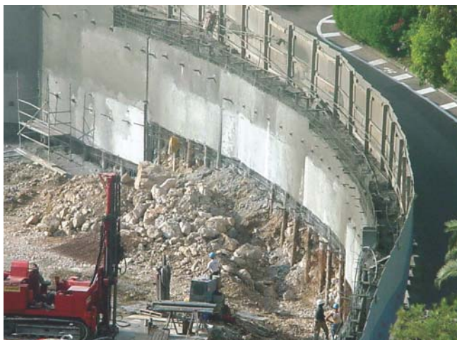
Travaux de berlinoise
