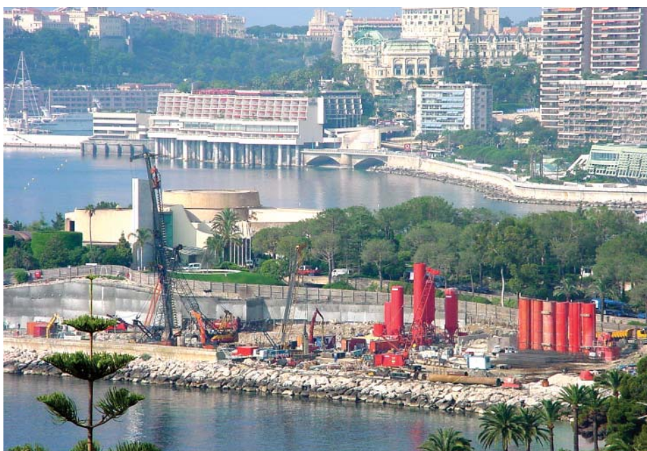
Vue d'ensemble du chantier
