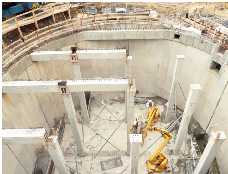
Mise en place des poutres préfabriqués
